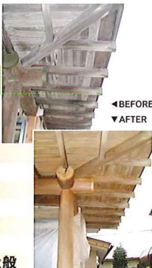
施工できる主な建築素材 素材により、8~11Hのコートを施します。
